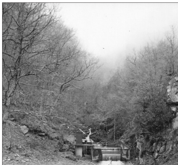
Εικόνα 1. Ο υδρομετρικός σταθμός στο στόμιο της λεκάνης με απορροή παραγόμενη κυρίως από το λιώσιμο χιονιού στις υψηλότερες θέσεις της (5 Απριλίου 1996)
