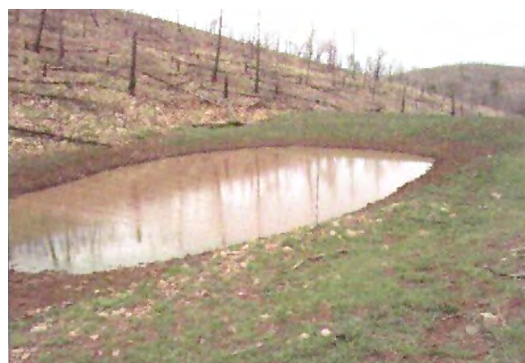
Εικόνα 19. Μικρός τεχνητός ταμειωτήρας συγκράτησης φερτών υλικών στον πόδα λόφου σε καμένο δάσος (Napper, 2006).
