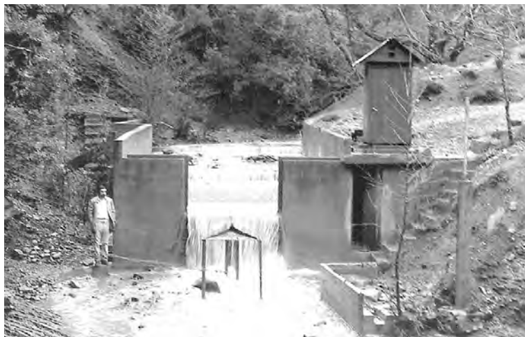
Εικόνα 2. Ο υδρομετρικός σταθμός στο στόμιο της λεκάνης απορροής. Picture 2. The hydrometric station in the outlet of the watershed.
