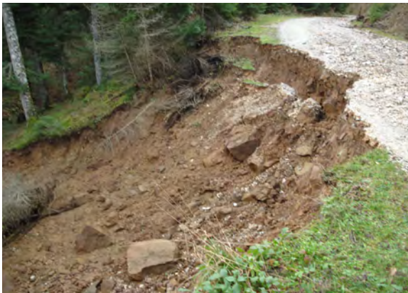
Εικόνα 2. Κατολίσθηση πρανούς περιφερειακού δασικού δρόμου «Βαθύ» στο Πανεπιστημιακό δάσος Περούλιου (Διοίκηση Παν/κού Δάσους Περούλιου, 2010).
