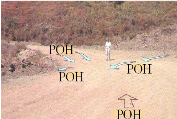
Εικόνα 15. Σημεία συγκέντρωσης υδάτων σε δασικό δρόμο (Ψιλοβίκος, 2010).
