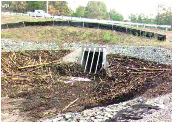
Εικόνα 18. Εσχάρα αποτροπής εισόδου φερτών υλικών σε έξοδο οχετού (Napper, 2006).
