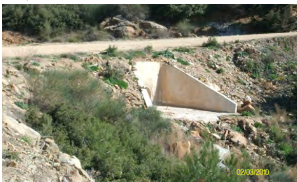
Εικόνα 6. Σωληνωτός οχετός με περυγότοιχους στο δασικό δρόμο Α1Τ1 (Ψιλοβίκος, 2010).
