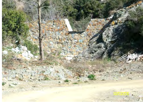
Εικόνα 17. Μικρό φράγμα πλησίον του δασικού δρόμου Α2Τ2 προσαρμοσμένο στο περιβάλλον (Ψιλοβίκος, 2010).
