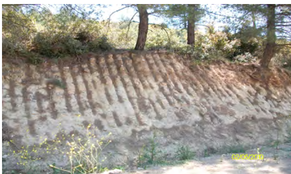
Εικόνα 4. Διαμόρφωση πρανών με χρήση μηχανικού εκσκαφέα (Ψιλοβίκος, 2010).
