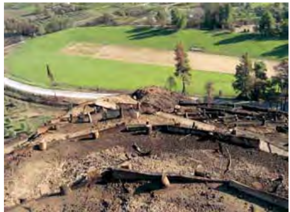
Εικόνα 11. Κορμοδέματα στη κορυφή του Κρόνιου λόφου Ολυμπίας (Μπαλούτσος κ.ά., 2007).
