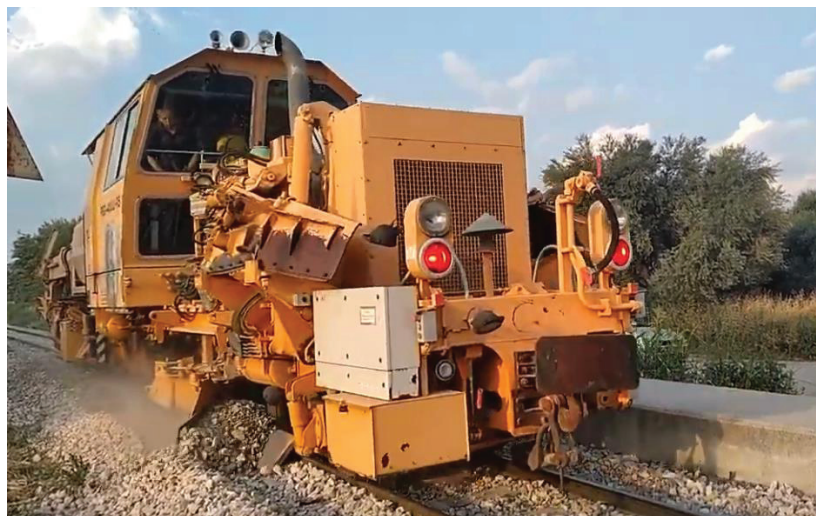
Εικόνα 2 - Ρεγκαλέζα (ballast regulator)
