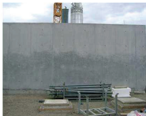
Εικόνα 8 - Εμφανής διαφορά απόχρωσης (μη αποδεκτή)
