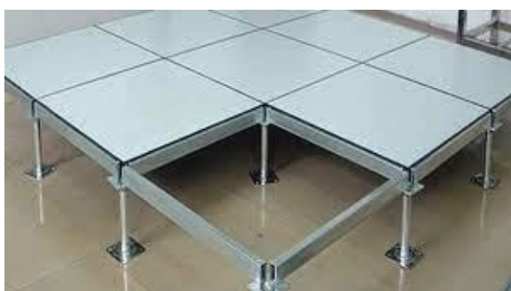
Σχήμα 1 - Συστατικά μέρη ενός υπερυψωμένου δαπέδου
