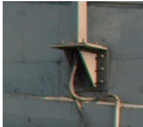
Εικόνα 4: Χαλύβδινη διάταξη στήριξης ιστού σε όψη τοίχου
