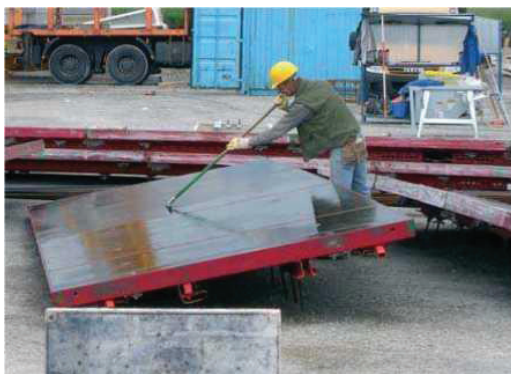
Εικόνα 1 - Ομοιόμορφη εφαρμογή αντικολλητικού με λαστιχένια σπάτουλα
