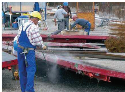
Εικόνα 2 - Εφαρμογή αντικολλητικού με ψεκασμό
