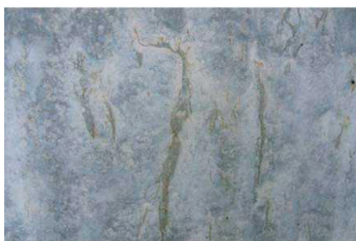
Εικόνα 4 - Χρωματικές αλλοιώσεις λόγω υπερδοσολογίας αποκολλητικού
