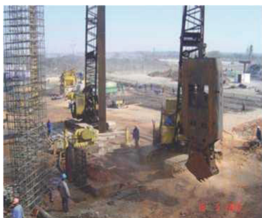
Εικόνα 3 - Αρπάγες μηχανικής λειτουργίας με συρματόσχοινο (μπένες)
