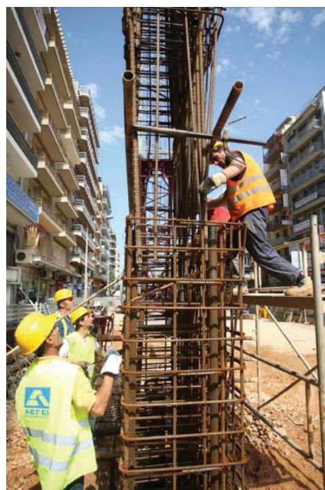
Εικόνες 6, 7 και 8 - Διαδικασία τοποθέτησης κλωβού οπλισμού
