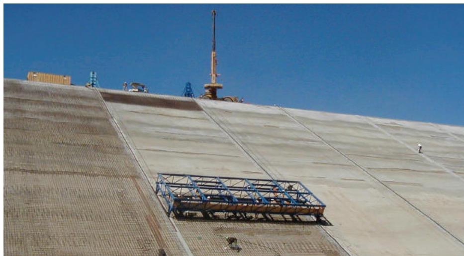
Εικόνα 3 - Τυπικό φορείο τοποθέτησης σιδηροπλισμού
