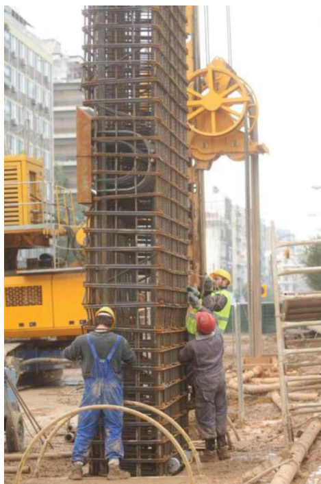
Εικόνες 6, 7 και 8 - Διαδικασία τοποθέτησης κλωβού οπλισμού
