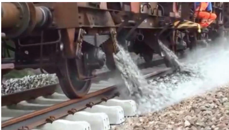
Εικόνα 2: Σκυρόστρωση
