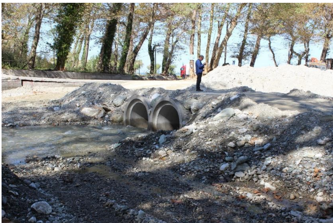
Πρόχειρη διάβαση του ρέματος, μέχρι να γίνει νέα γέφυρα.
