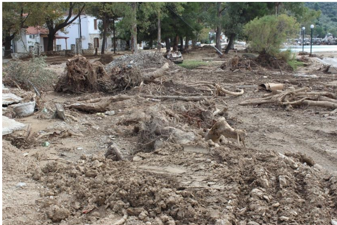
Καταστροφές στην παραλία του οικισμού που δημιούργησε ο χείμαρρος Αμμόρεμα.
