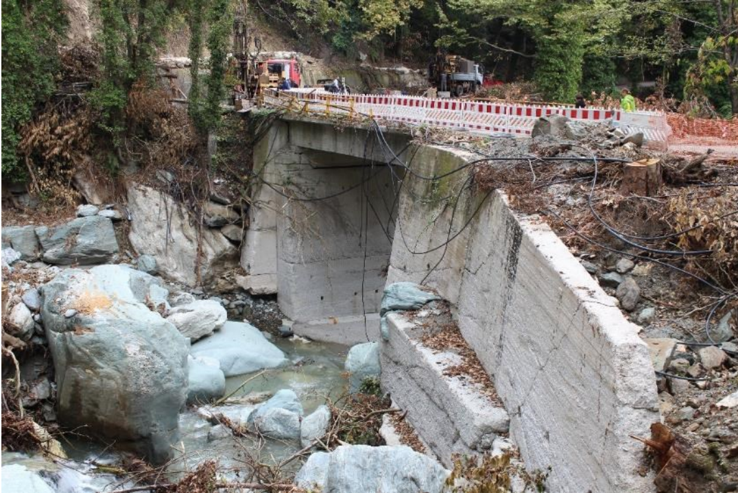
Καταστροφές στους πτερυγότοιχους του ρέματος Καλοκαιρινού.
