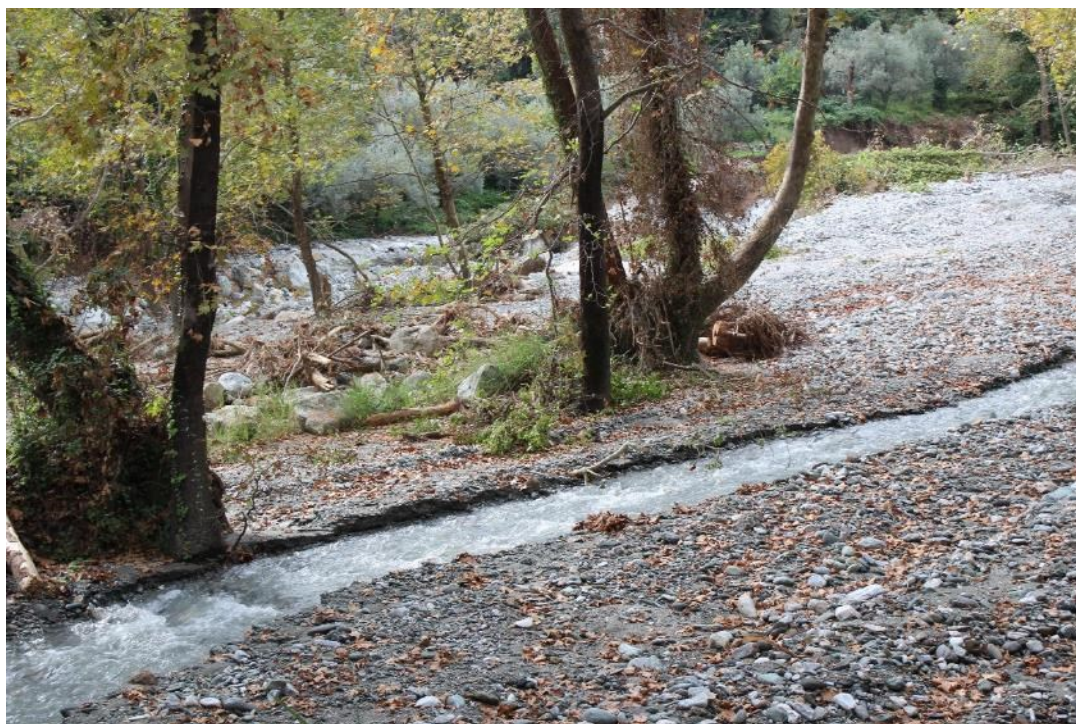
Απόθεση φερτών υλικών και δέντρων στην κοίτη του ρέματος.
