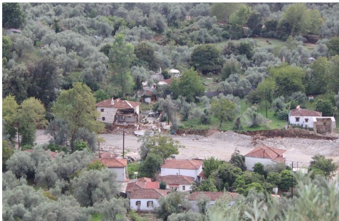
Τοίχος κτίσματος του οικισμού Πηγές που παρασύρθηκε από το Αμμόρεμα.
