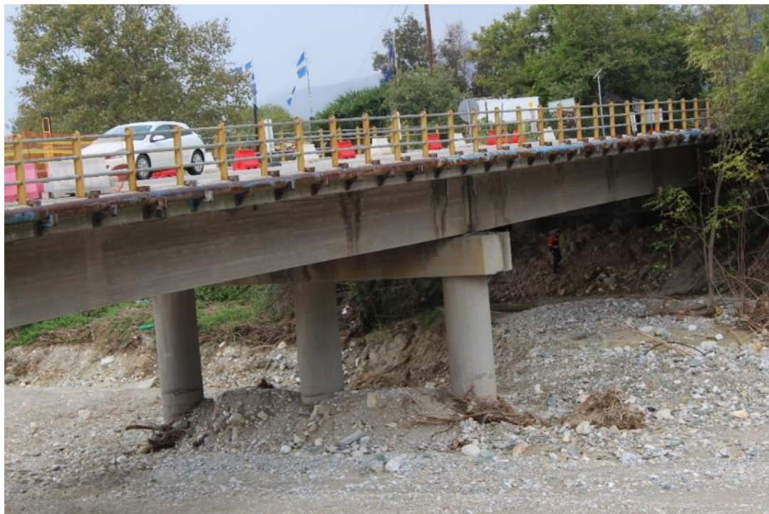
Η γέφυρα στο ποτάμι μεταξύ Καλών Νερών και Μπούφα
