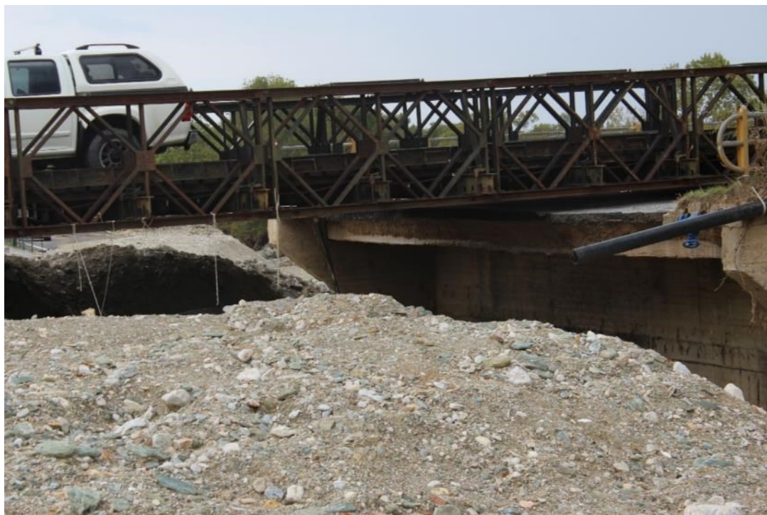
Γέφυρα τύπου Bailey στο ποτάμι μεταξύ Καλών Νερών και Μπούφα
