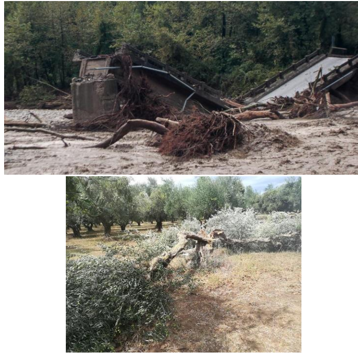
Εικόνα 2.3.1. Παραδείγματα καταστροφών από τους μεσογειακούς κυκλώνες Ζορμπάς και Ιανός. (Πηγές: messinialive.gr , thetoc.gr )
