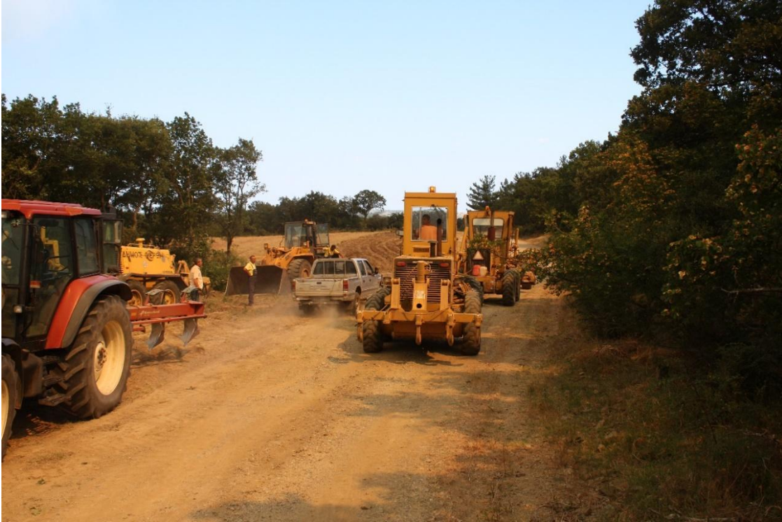
Εικόνα 4.2.3. Κατασκευή αντιπυρικής ζώνης με χρήση χωματουργικών μηχανημάτων κοντά σε οικισμό.
